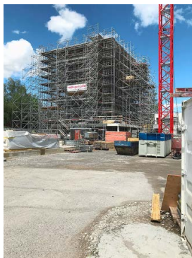
Im Bau: Das neue Gemeindehaus.
